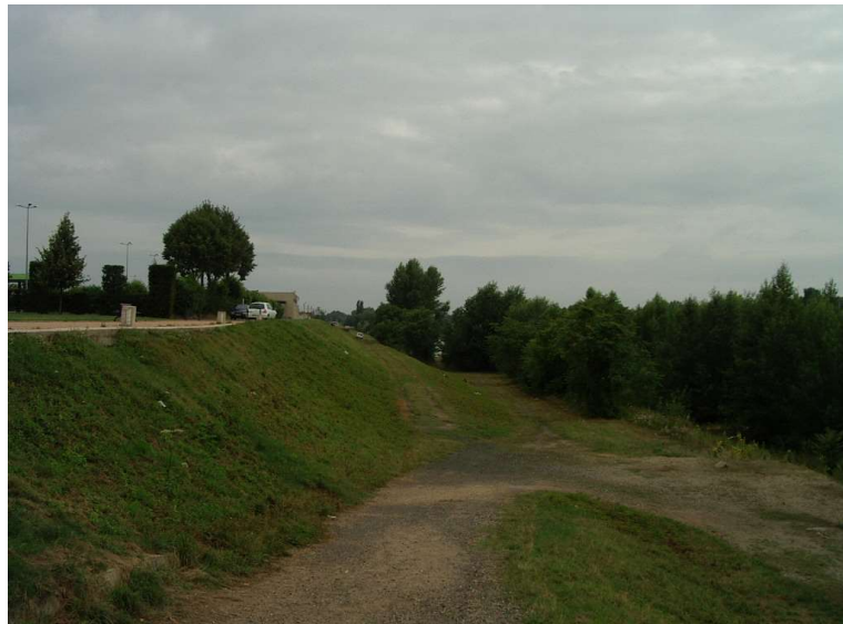
Digue de la Charbonnière, rive gauche de l'Allier à Moulins (Source : DDT03)
