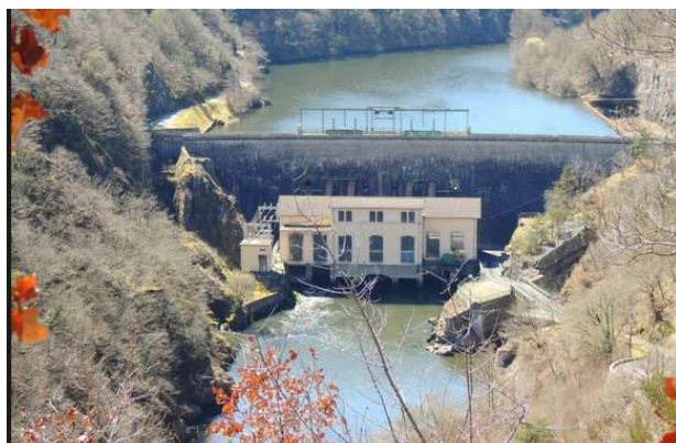
Barrage de Queuille (Source : Pays d'Auvergne)
