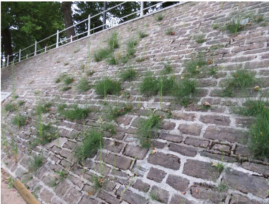
Exemple de végétation fixée sur la digue Napoléon III à Vichy avant travaux en 2021 (Source : DDT 03)
